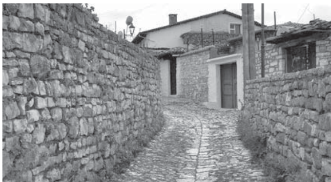
Quartiere della cittadella o del Kala (abbreviazione di Kalaja/Castello), costruito tra il XV-XVI secolo, all'interno della fortezza Medioevale.
