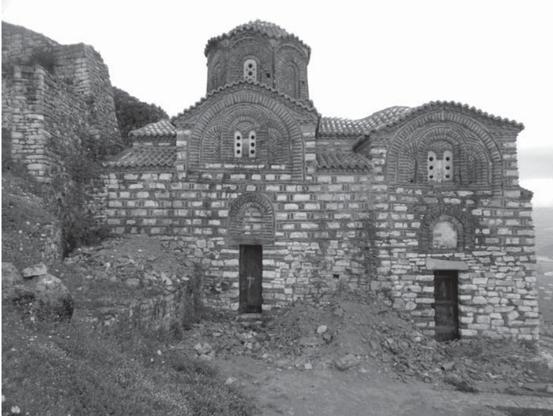
Berat, Chiesa della Santissima Trinità (XIII – XIV sec.). Si noti l'uso da parte delle maestranze bizantine della tecnica costruttiva del cloisonné o castone, (foto dell'Autore).
